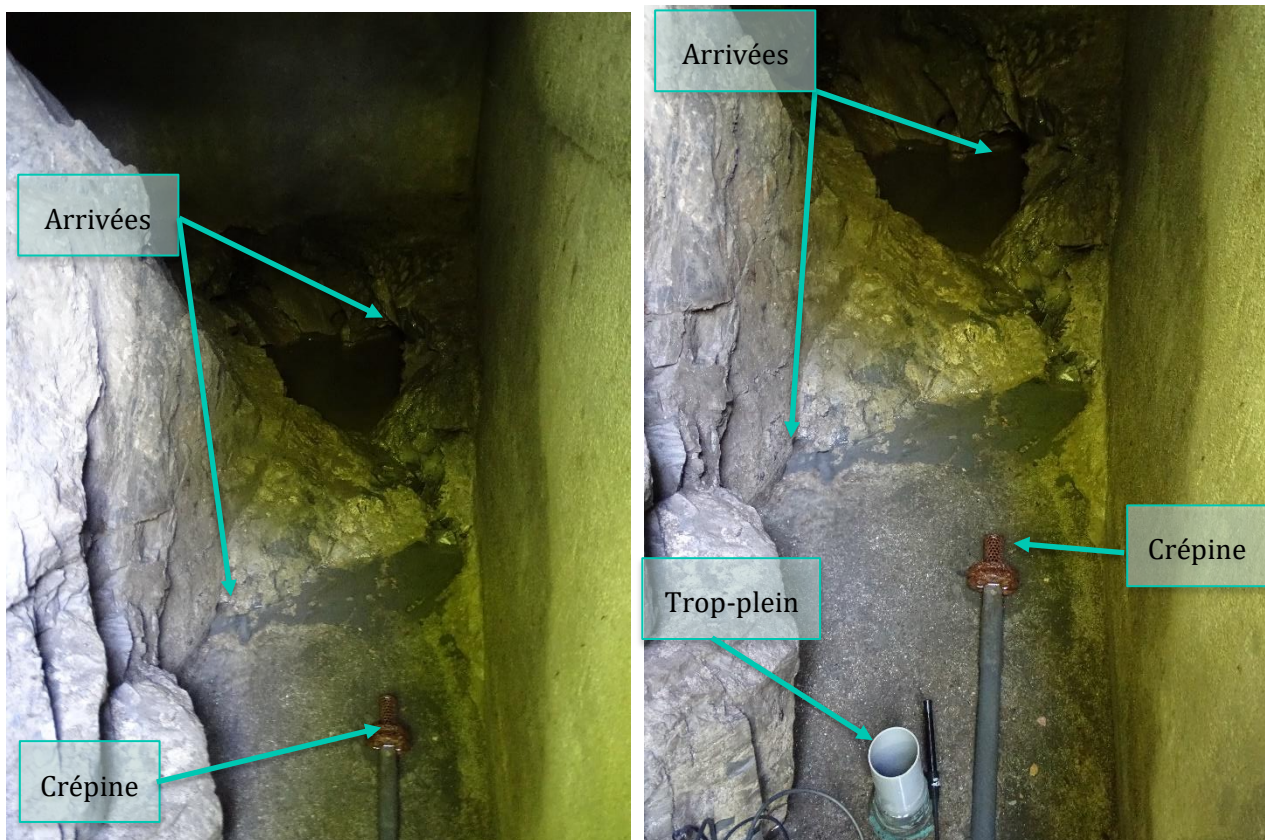
Illustration 14 : Clichés de l'intérieur du captage de « Source de l'Argen »
