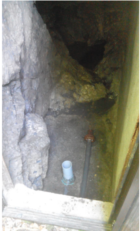
Intérieur du captage, roche calcaire massive, crépine et trop plein après le seuil
