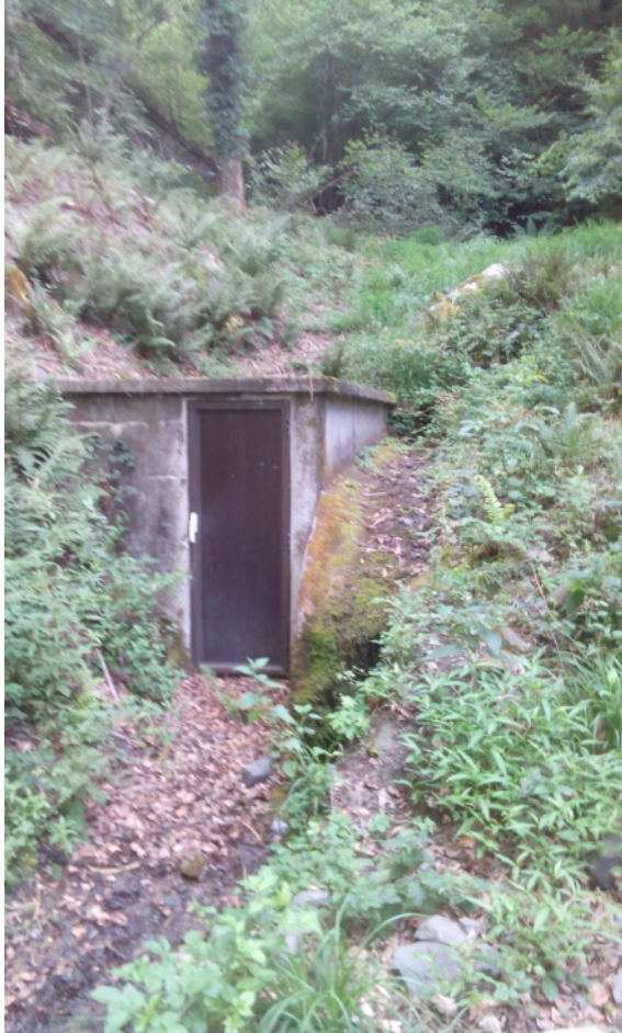
Captage, porte et seuil
